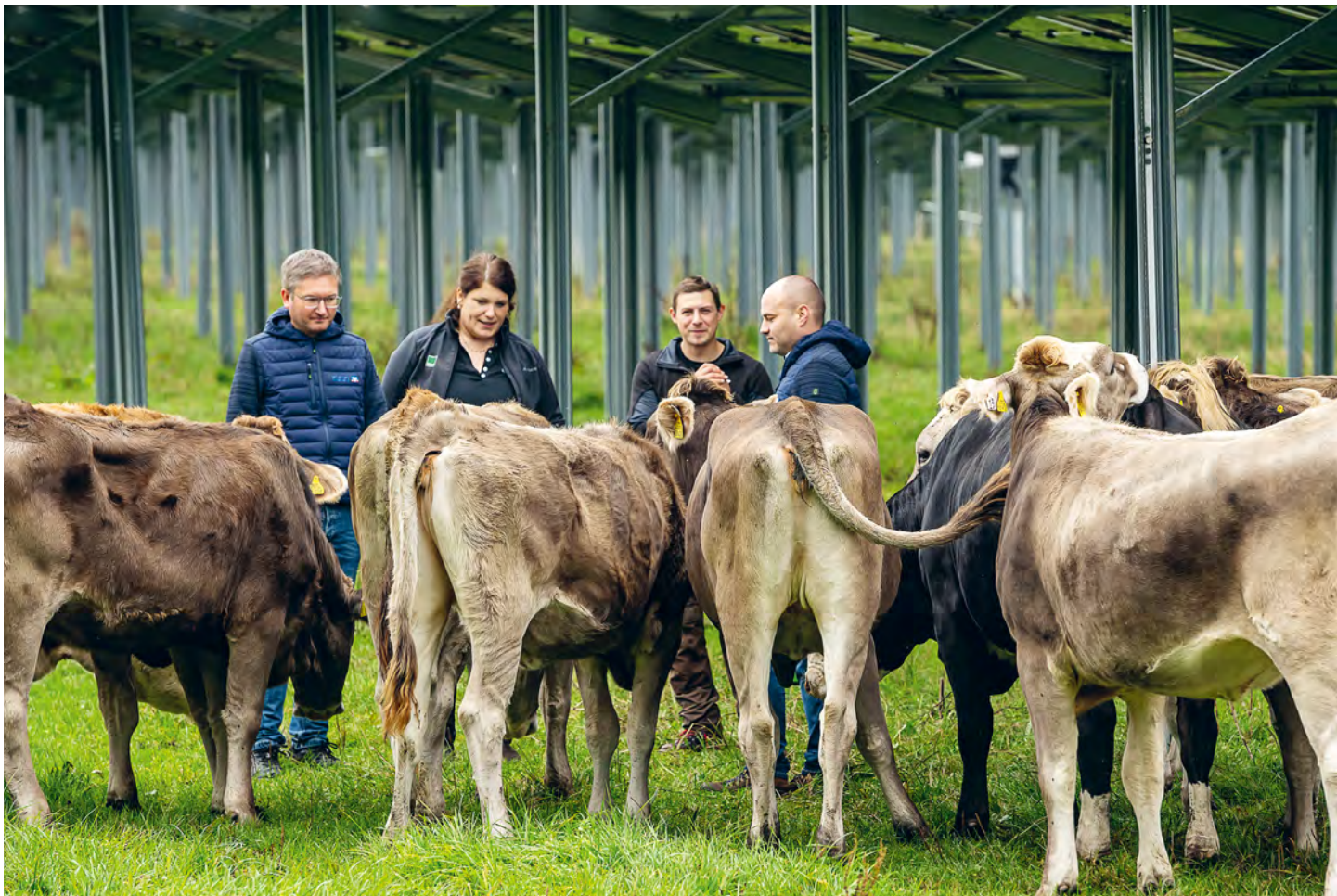
Unten: Möglich wird die Kombination aus Landwirtschaft und Energieerzeugung, weil die Module so hoch stehen, dass die Tiere darunter laufen und stehen können.
